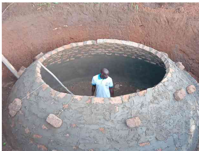
Bau des Biogasdoms
