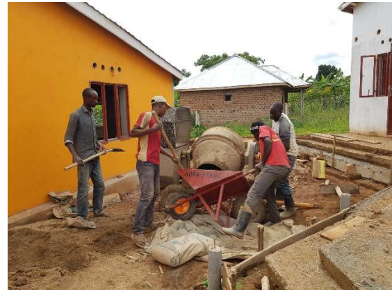
Abbildung 22: Schubkarre in Aktion auf der Baustelle
