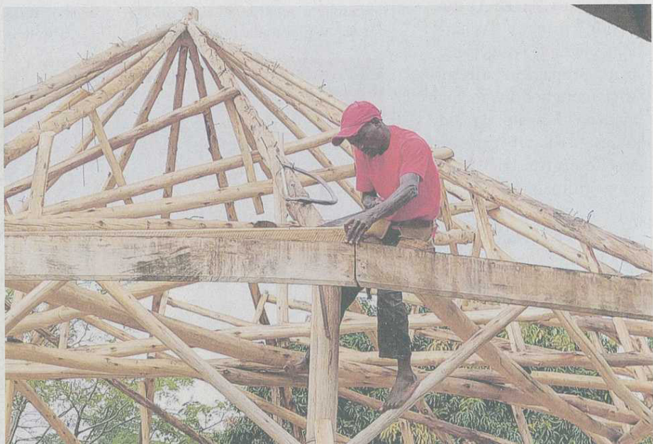
Vid construir in tetg.
